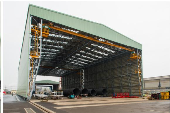
住友重機械搬送システム株式会社様は、造船所や製鉄所などで使われる大型のクレーンや、海外から輸入した石炭や鉄鉱石を荷揚げする機械を製造しています。大型製品の組立を行う屋外組立ヤードに、さまざまな大きさや形状の製品に合わせて建屋の位置を自在に変更できるように駆動装置を内蔵した移動建屋を2棟新設。「総重量約300トンの建屋を100m移動させますが、音が静かで使い勝手もよい」と好評をいただきました。
